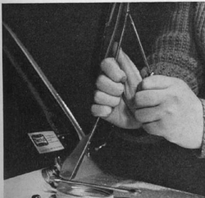
Die Scheibenwischerblätter sollten zweimal pro Jahr, jedoch auf jeden Fall im Herbst erneuert werden. Zur Demontage des Wischerblattes mit schmalen Schraubenzieher am Wischerarm unter das Haltestück des Wischerblattes drücken und dieses über einen kleinen Nocken am Wischerarm hebeln.
