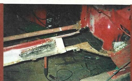
...verrotet. Schneider gab die Karosserie einem Profi, der alle Blechteile originalgetreu anfertigte
