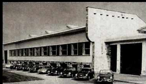
Bereits 400 Arbeiter am Start: Abarth-Fabrik zu Beginn der Sechziger, am Corso Marche in Turin. Die Firma produziert inzwischen eine Viertelmillion Auspuffanlagen im Jahr
