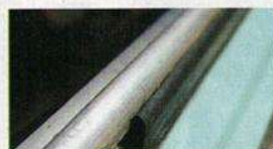
Rückzug: über die Jahre geschrumpfte Dichtung
