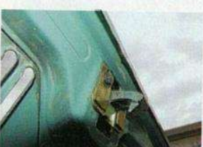
Hauben: Nur Kantenrost kann zum Problem werden
